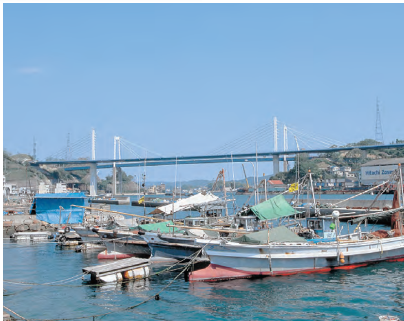
尾道市／尾道大橋
